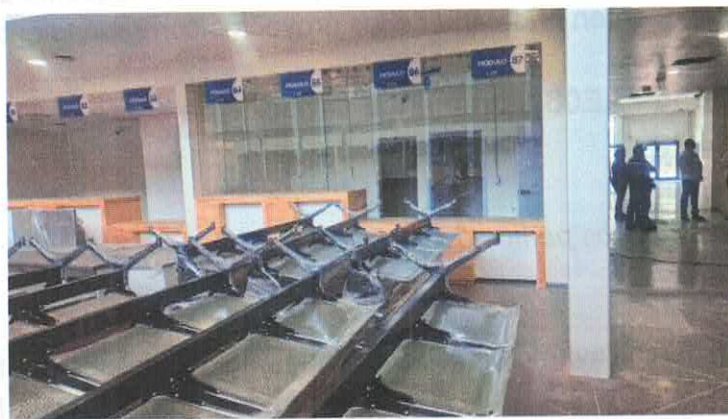
Figura 4. Avances en instalación de punto de atención. CAM Junio 2025.
