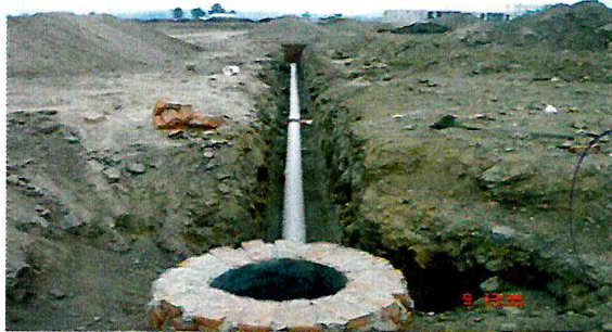
SUPERVISIÓN DE RED DE DRENAJE SANITARIO EN EL FRACCIONAMIENTO TIERRA NUEVA
