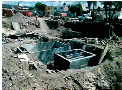
CONSTRUCCIÓN DE RED DE DRENAJE SANITARIO Y PLANTA DE TRATAMIENTO EN LA COMUNIDAD CAMINO REAL DE LO DE JUÁREZ (1A ETAPA)
