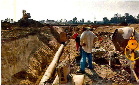
SUPERVISIÓN DE RED DE DRENAJE SANITARIO, Y PLUVIAL EN EL PARQUE CENTRAL GUANAJUATO
