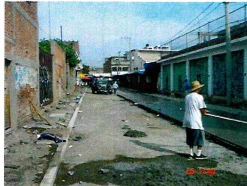
CALLE: ROBERTO FIERRO TRAMO: C. PROGRESO A J. J. TORRES LANDA COLONIA: RODRÍGUEZ
