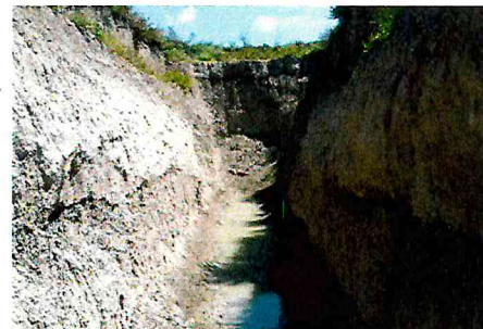
SUPERVISIÓN EN EL PARQUE GUANAJUATO CENTRAL
