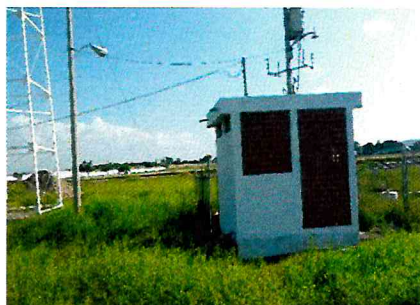
SUPERVISIÓN DE EQUIPAMIENTO EN EL SMART PARK
