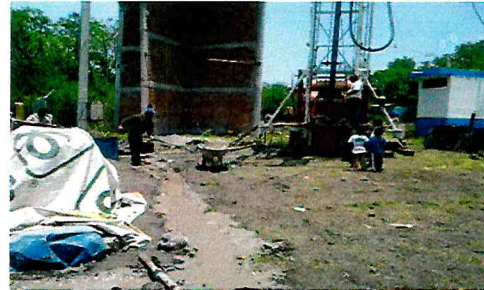
PERFORACIÓN DE POZO PROFUNDO EN LA COMUNIDAD DE VENADO DE SAN LORENZO.
