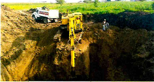
CONSTRUCCIÓN DE COLECTOR Y CÁRCAMO DE BOMBEO EN LA COMUNIDAD DE STA. ELENA (1A ETAPA).
