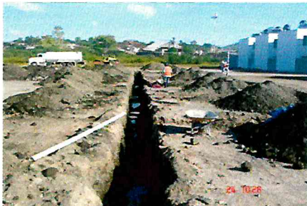
SUPERVISIÓN DE RED DE DRENAJE SANITARIO Y RED DE AGUA POTABLE EN EL FRACCIONAMIENTO VILLAS DEL BERNALEJO
