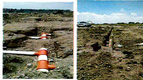
SUPERVISIÓN DE RED DE DRENAJE SANITARIO EN EL FRACCIONAMIENTO COLINAS DEL RIO II
