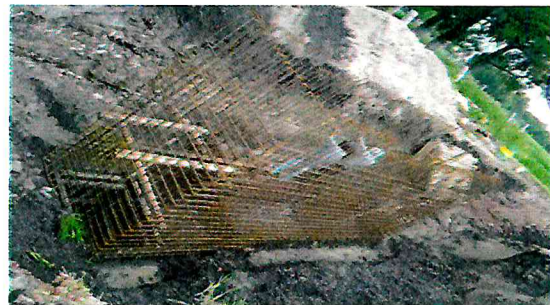
DRENAJE SANITARIO Y SISTEMA DE TRATAMIENTO PRIMARIO EN LA COMUNIDAD DE ROSARIO DE COVARRUBIAS (1RA ETAPA).
