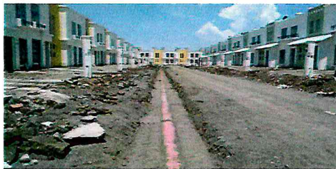
SUPERVISIÓN DE RED DE DRENAJE SANITARIO EN EL FRACCIONAMIENTO PALMA DE MALLORCA.
