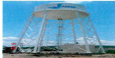
SUPERVISIÓN DE TANQUE ELEVADO PARA EL FRACCIONAMIENTO VALLERREAL
