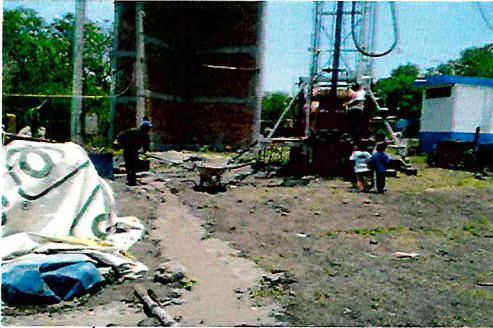
PERFORACIÓN DE POZO PROFUNDO EN LA COMUNIDAD DE VENADO DE SAN LORENZO.
