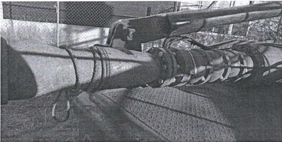
SE DESINSTALARON UN TOTAL 18 TRAMOS DE TUBO DE COLUMNA DE 8", DE 6.10 MTS., DE LARGO APROX. ( 110.00 MTS DE COLUMNA DE ACERO), ADEMÁS 8 TRAMOS DE TUBO DE PV.C., DE 8" ( 48 MTS).
