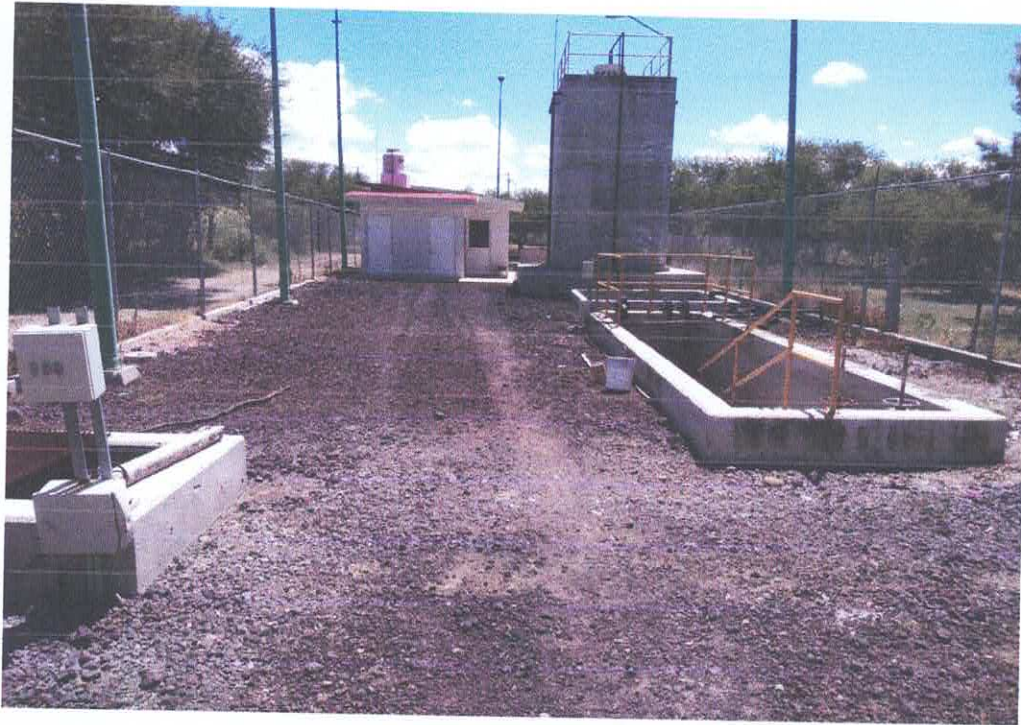
PTAR de PASO BLANCO
