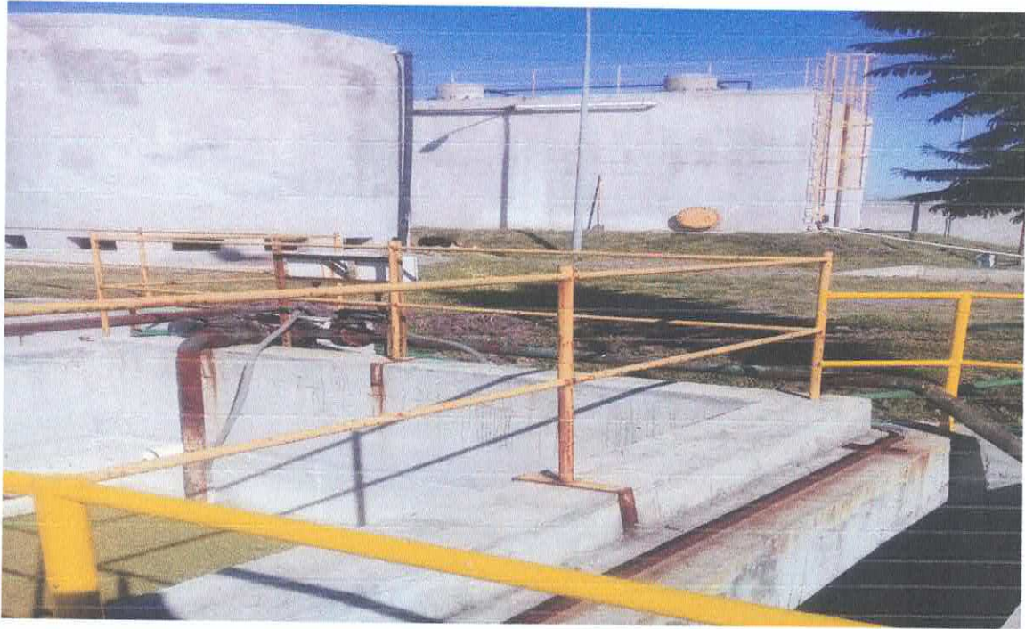
PTAR DE SAN ROQUE
